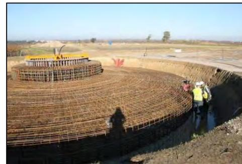
Photo 13 : ferrailage de la fondation
