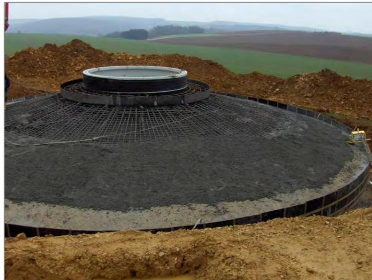
Photo 1 : exemple de ferrailage en radier pour une éolienne
