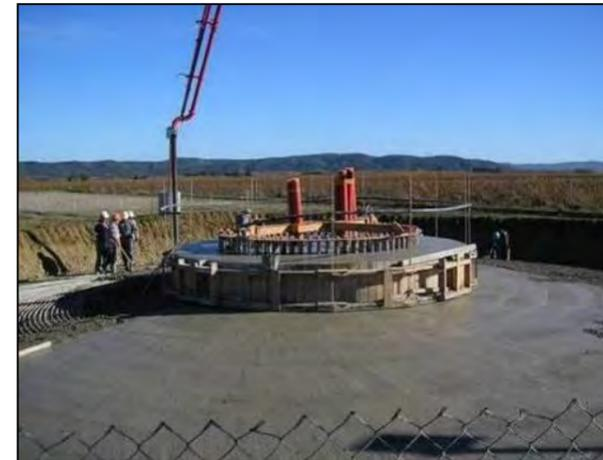
Photo 14 : coulage du béton
