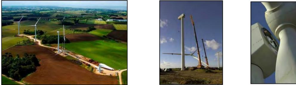
Photo 18 : hissing et assemblage du rotor
