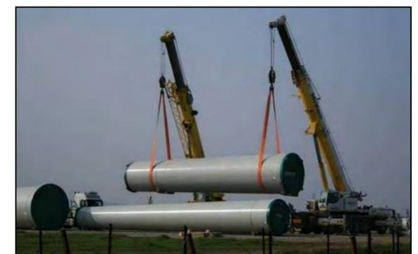
Photo 7 : manipulation des tronçons d'éoliennes
