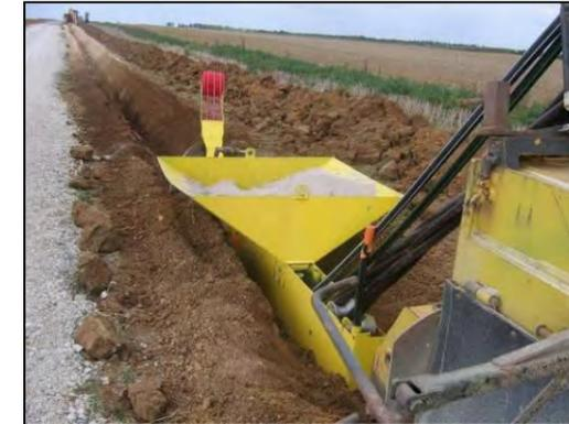
Photo 5 : engin utilisé pour le creusement de la tranchée et la pose des câbles électriques
