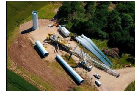
Photo 16 : vue d'ensemble des étapes d'assemblage de la tour [exemple de tour en acier]
