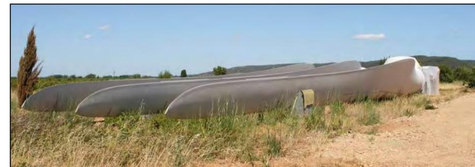
Photo 8 : pales entreposées sur un chantier éolien
