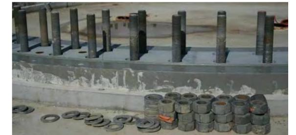
Photo 3 : détail des fixations de la fondation
